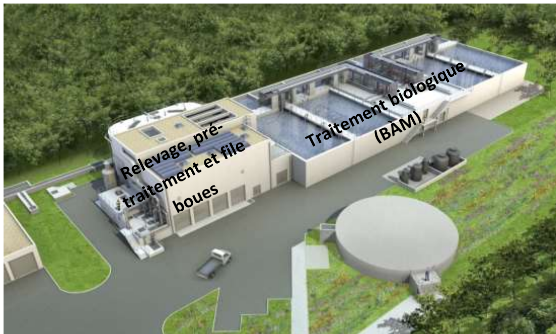
Figure II-3: Vue aérienne de la station de la Grande Motte
