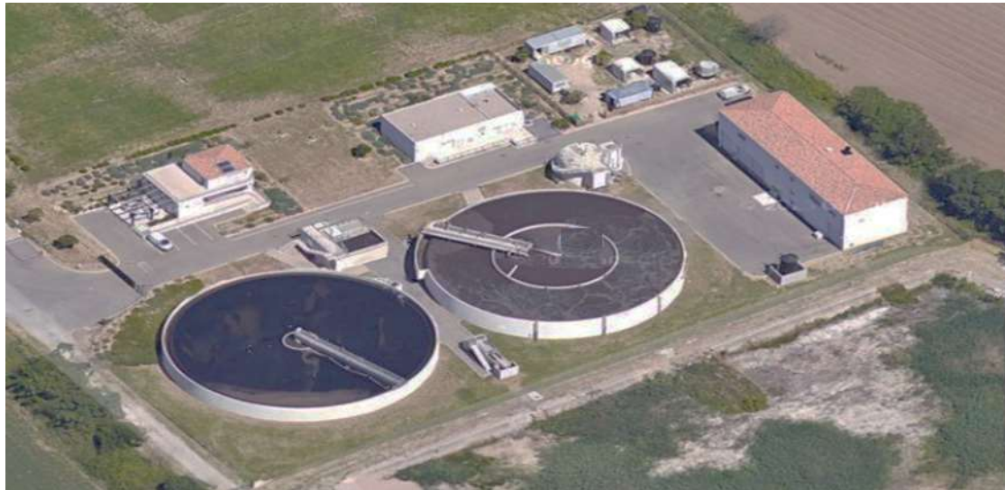
Figure II-5: La station des boues activée de Mauguio
