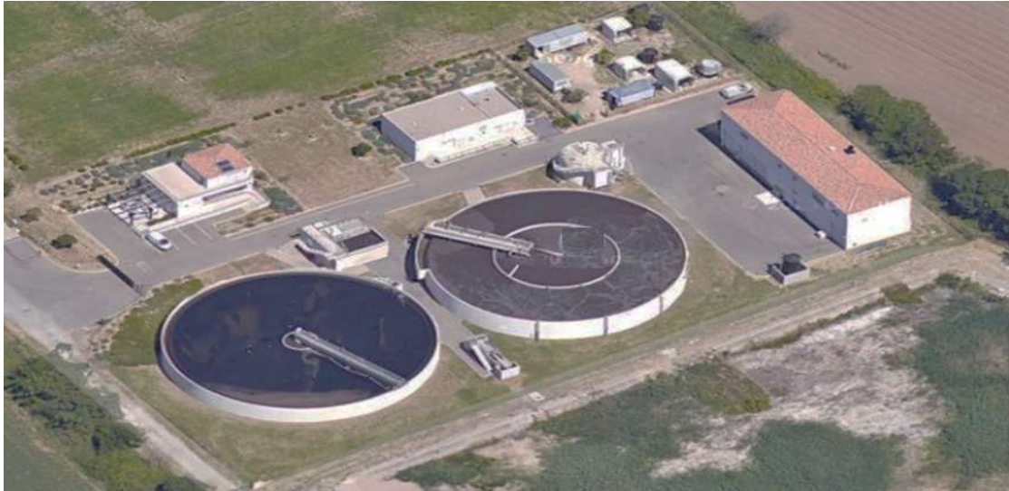
Figure II-5: La station des boues activée de Mauguio
