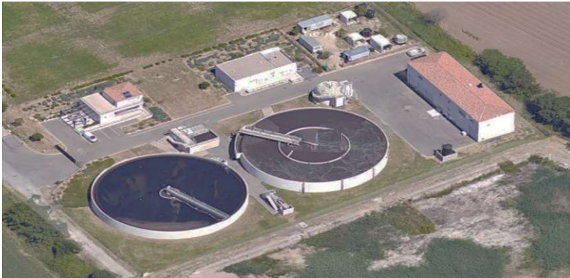
Figure II-5: La station des boues activée de Mauguio
