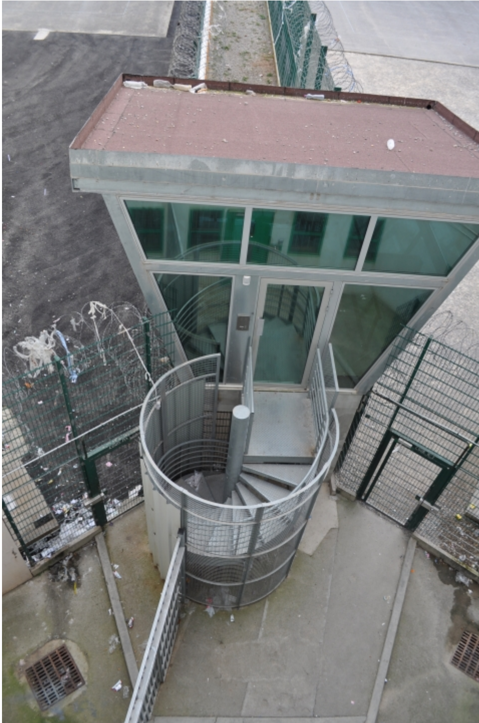
Photographie 10 : Espace de jonction des cours (©L. Solini)
