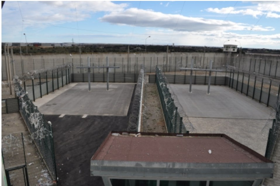
Photographie 12 : La cour des mineurs après les travaux (©L. Solini)
